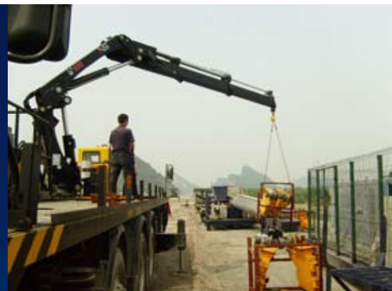
Lastbilskranar med fjärrstyrning var den bästa lösningen på grund av den ojämna terrängen.
