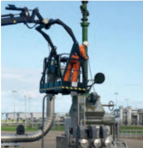
Mit der funkbasierten und ATEX-zertifizierten Fernsteuerung kann der Bediener auf der fahrbaren Hubarbeitsbühne den Kran und die Installation auf dem Eruptionskreuz mit hoher Präzision steuern.
